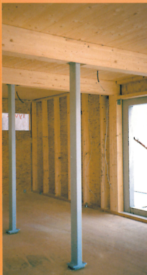
Vorgefertigte Wandelemente und massiv verleimte Holzdecken ermöglichen kurze Bauzeiten ohne Baufeuchte.
