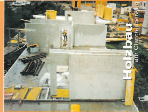
Errichtung der massiven Stieghäuser.
