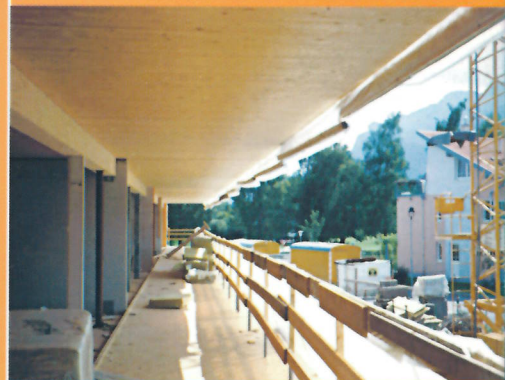
Die Veranden mit Absicherung während der Bauzeit.
