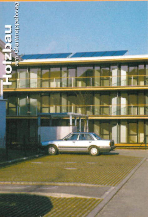
Die Solaranlage am Dach dient zur Warmwasserbereitung im Sommer und in der Übergangszeit.
