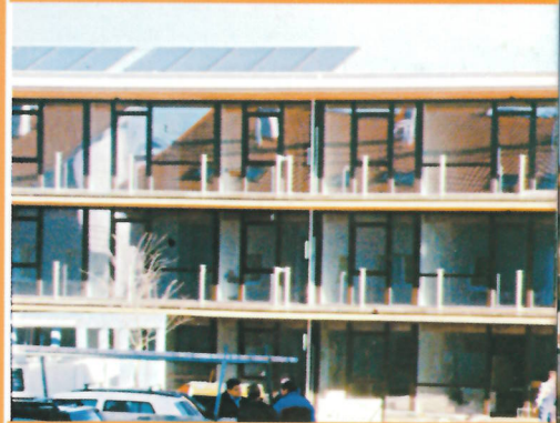
Die Südwestfassade ist fertig verglast und die Solaranlage am Dach montiert.
