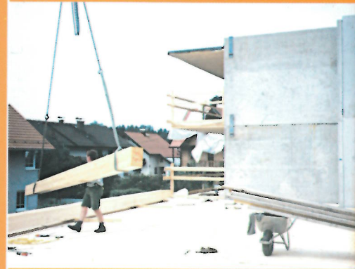
Die vorgefertigten Deckenelemente werden angeliefert und versetzt.
