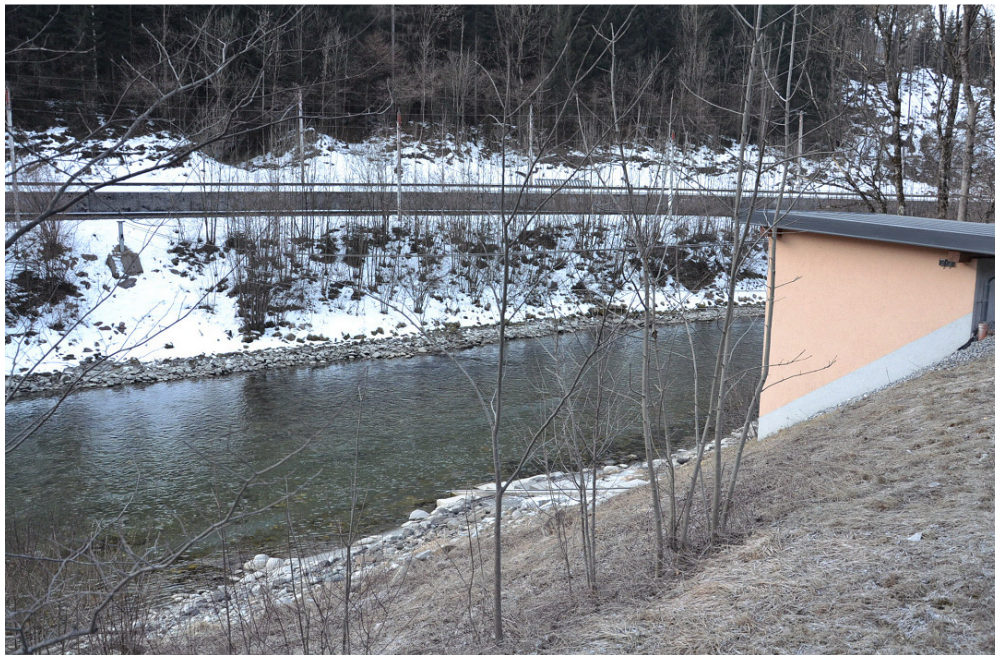
Abbildung 6 Bild Pegel Wallnerau NEU, Blickrichtung flussauf
