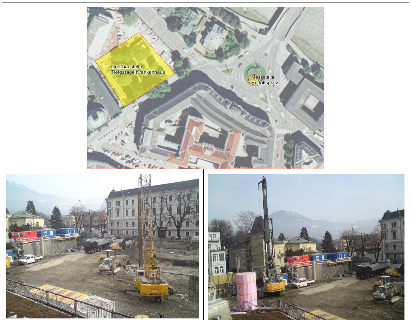
Abbildung 14: Lageplan sowie Bilder der Baustelle "Tiefgarage Krankenhaus Barmherzige Brüder"
