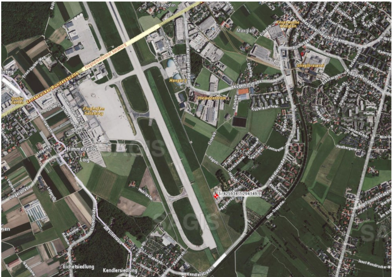
Abbildung 1: Aufstellungsort des Messcontainers
