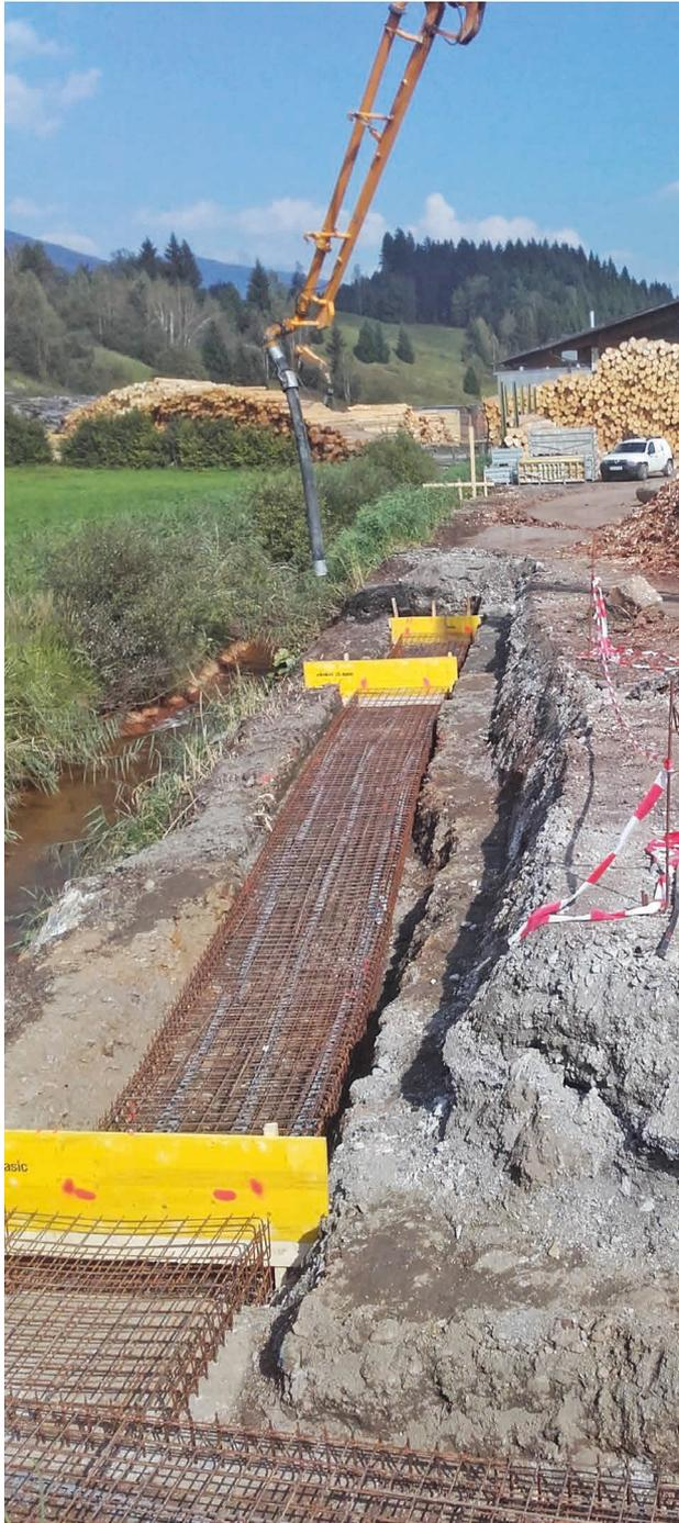
Fundament-Bewehrung Sägewerk Schnell
