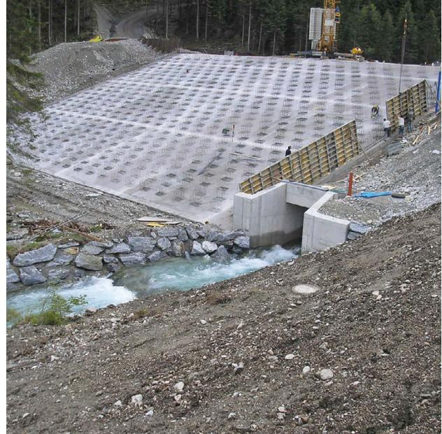
Betonarbeiten für Störkörper auf der HW-Entlastung
