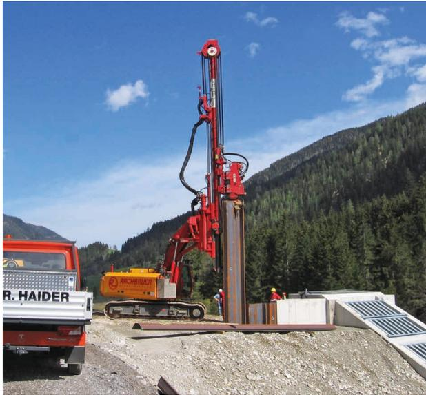
*Einbringung der Stahlpundwand zur Dammdichtung*
