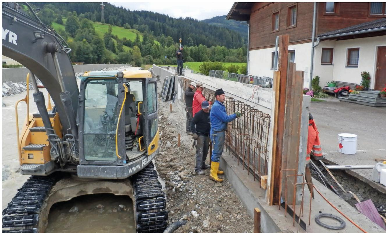
*Bewehrungsarbeiten an einer HW-Schutzmauer in Reitdorf*
