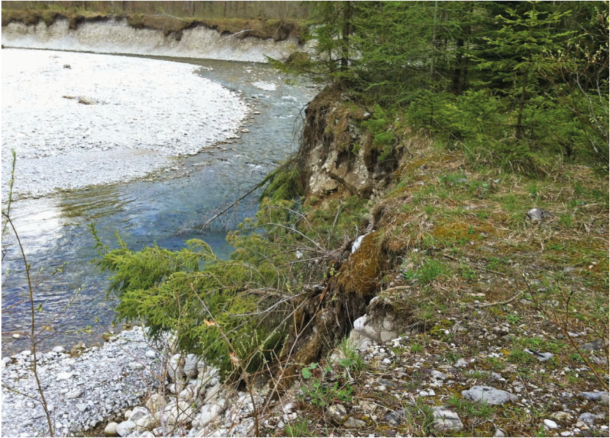
Abbildung 8: Die jahrzehntelange intensive Geschiebeentnahme hat zur Entkoppelung des Bachbetts vom umliegenden Gelände geführt (Foto: eb&p Umweltbüro GmbH)
