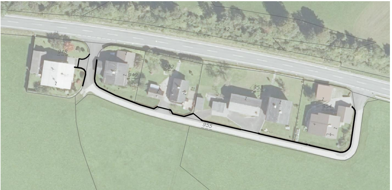
Abbildung 4: Lage der neu errichteten Hochwasserschutzmauer der Siedlung Oberscheffau (schwarz), ohne Maßstab
