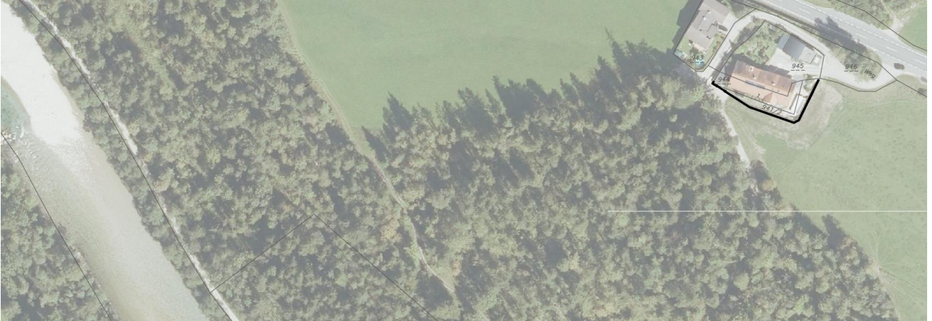
Abbildung 6: Lage der neu errichteten Hochwasserschutzmauer im Bereich Vorderleitner (rechts, schwarz), ohne Maßstab
