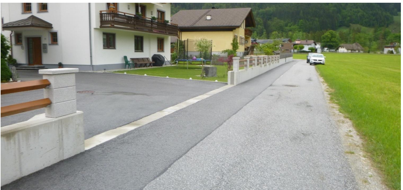
Abbildung 5: Hochwasserschutzmauer im Siedlung Oberscheffau
