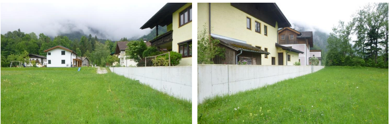
Abbildung 9: Hochwasserschutzmauer im Bereich Bernhof
