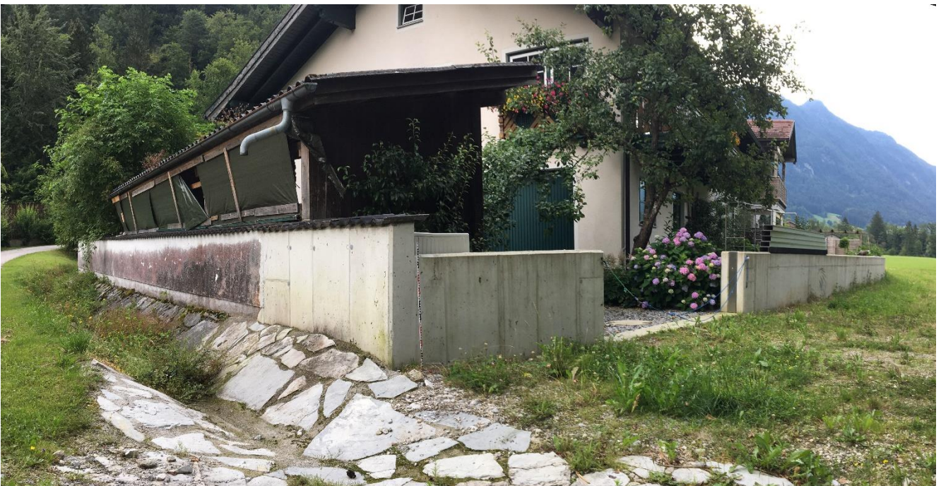
Abbildung 7: Hochwasserschutzmauer Vorderleitner, Ansicht Südwest
