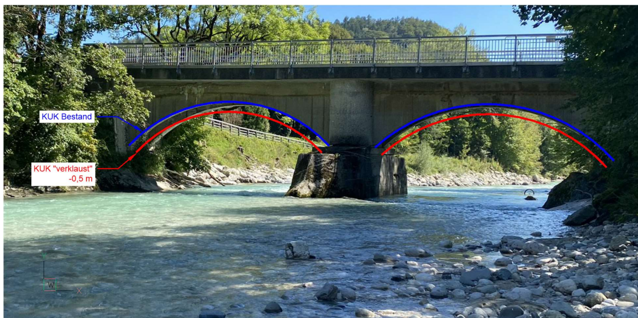
Abb. 7: Schematische Darstellung KUK-Absenkung bei Freibord &lt; ca. 0,5 m
