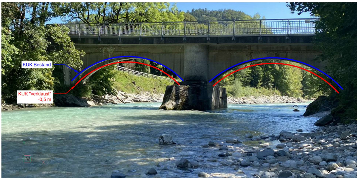
Abb. 7: Schematische Darstellung KUK-Absenkung bei Freibord < ca. 0,5 m
