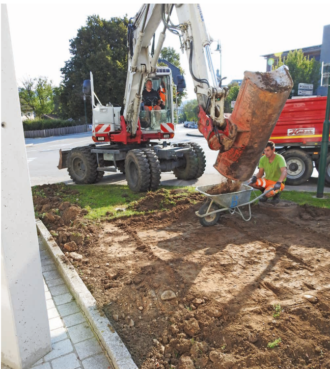
Rasensoden und je nach Beschaffenheit Boden abtragen.
