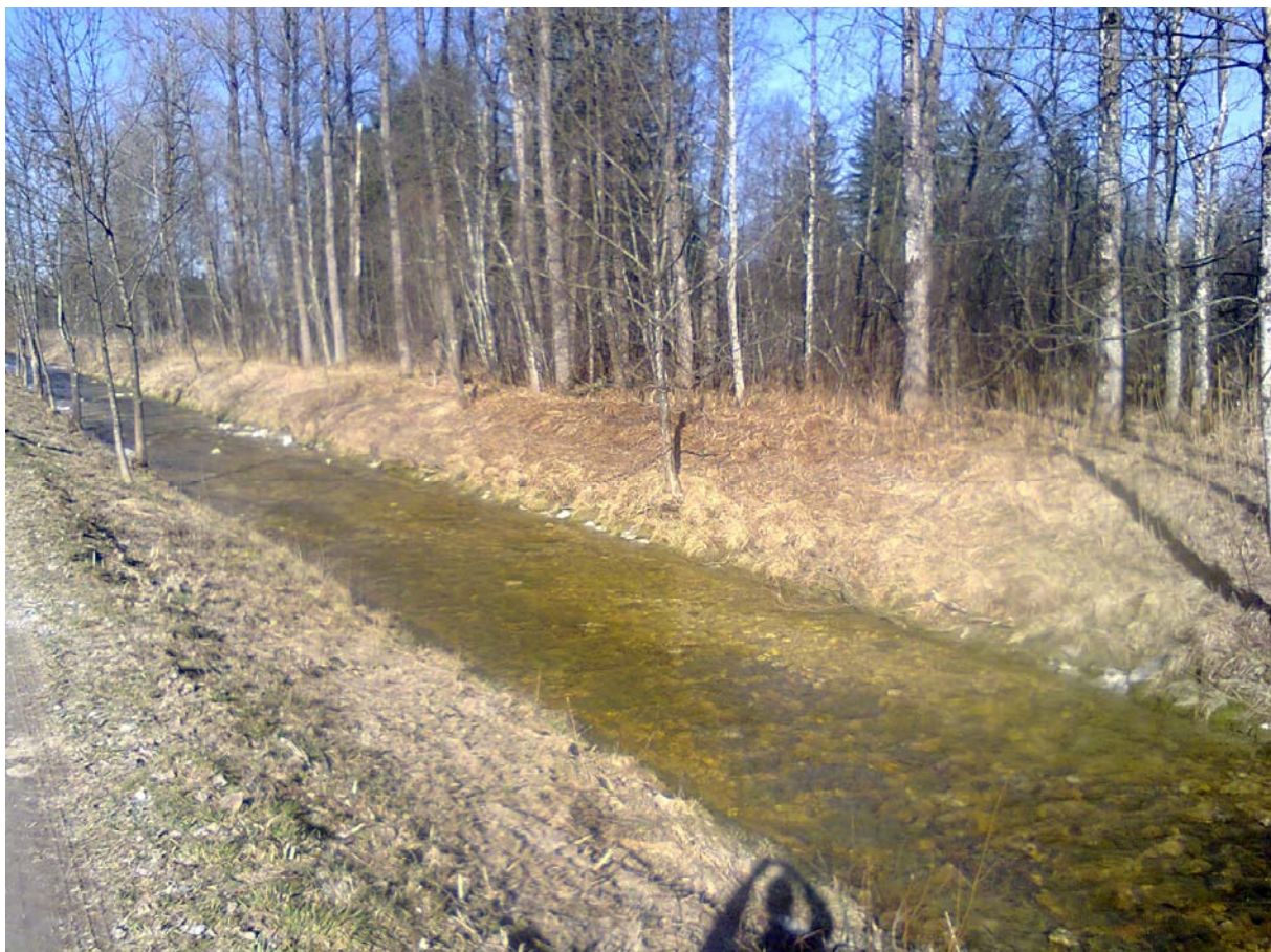
Abbildung 9: Glanbach unterhalb des Projektendes bis A10, gleichförmiges Trapezgerinne, Bereich der angenommenen Anlandungen
