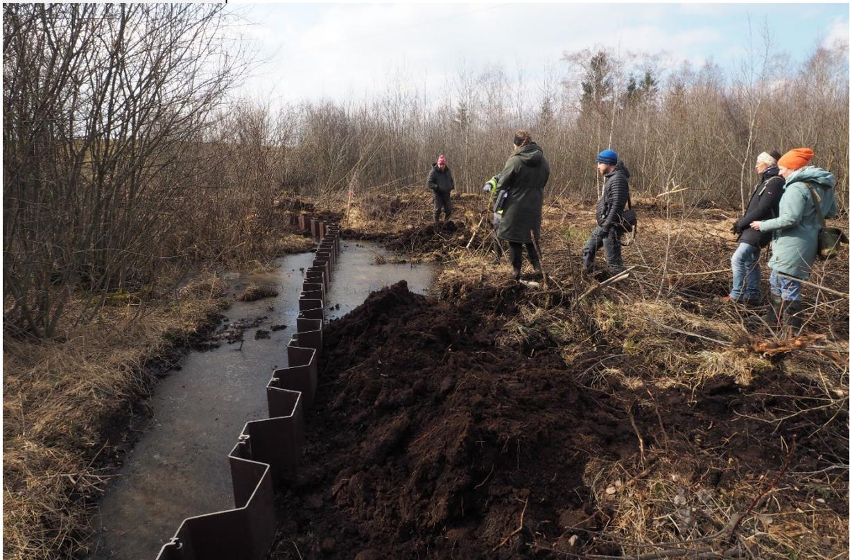
Spundbohlenwand aus Recycling-Kunststoff vor der Überdeckung mit Torf und Vegetation, Stufe B,
