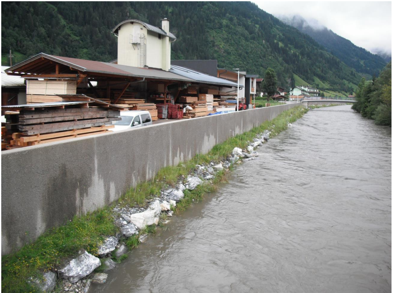
Abb. 5: HWS-Mauer rechtsufrig, ca. Fluss-km 8,1
