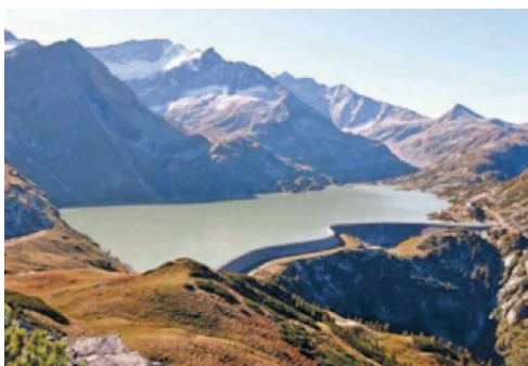
Abb. 12 Kraftwerk Tauernmoos der Kraftwerksgruppe Stubachtal.
