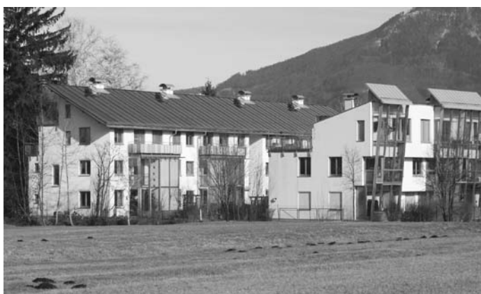
Landesenergiepreisträger Solarsiedlung Gneis Moos, © Josef Reithofer
