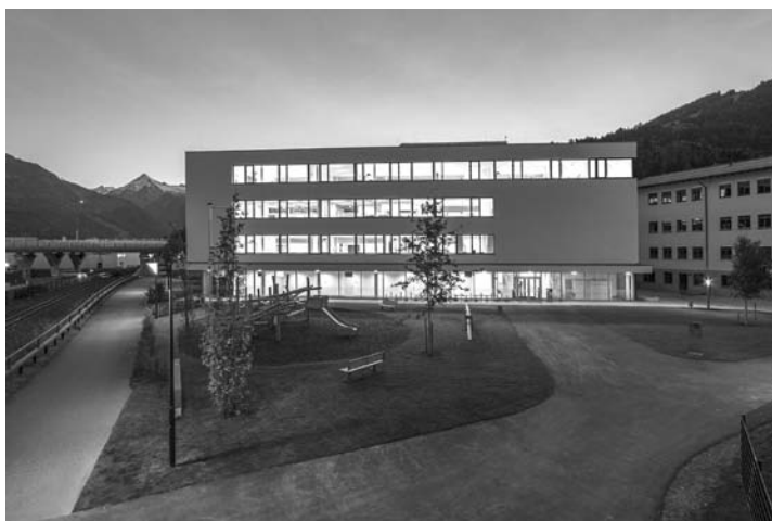
Passivhausschule Schulzentrum Schüttdorf (© Nikolaus Faistauer Photography)
