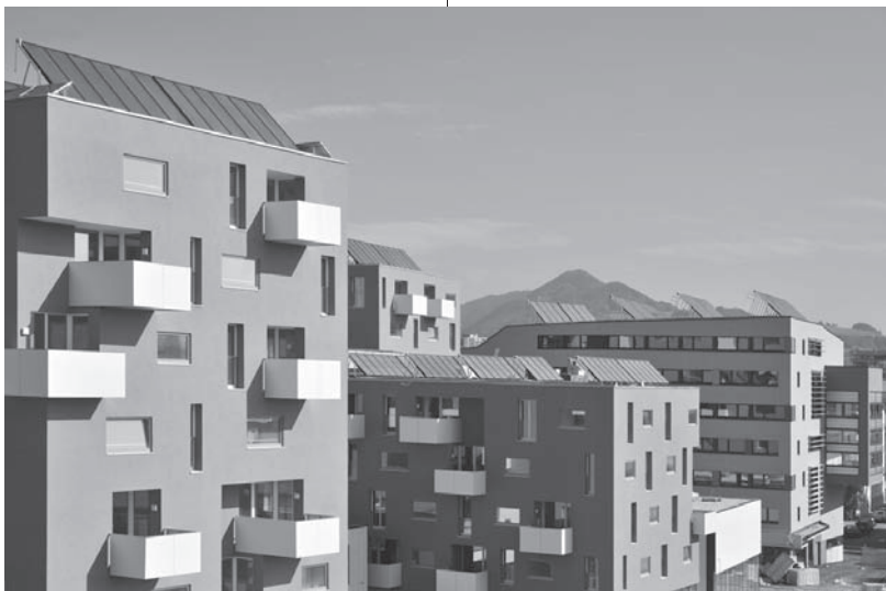
Mit 2000 m 2 Kollektoren ist im Stadtwerk Lehen die größte Solaranlage Salzburgs in Betrieb.
