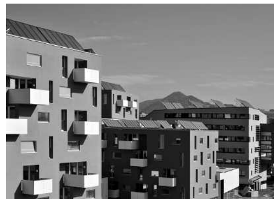
Neue Wohnungen und ein Studentenwohnheim am STADTWERK LEHEN. Die Solaranlage liefert bis zu 1/3 der notwendigen Wärme. (Bild: Fotohof)
