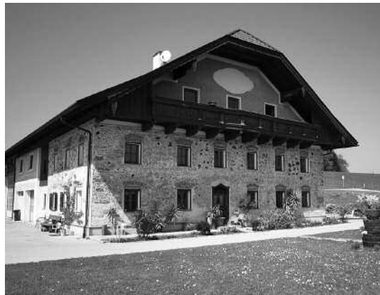
Eine Besonderheit im Flachgau sind die Schlackenputz-Gebäudefassaden. Diese wurden im 19. Jahrhundert von italienischen Wanderarbeitern verbreitet. Die Fassade des 1892 errichteten Obergirlingerhofes wurde 2002 aufwändig saniert. (Bild: Aster)
