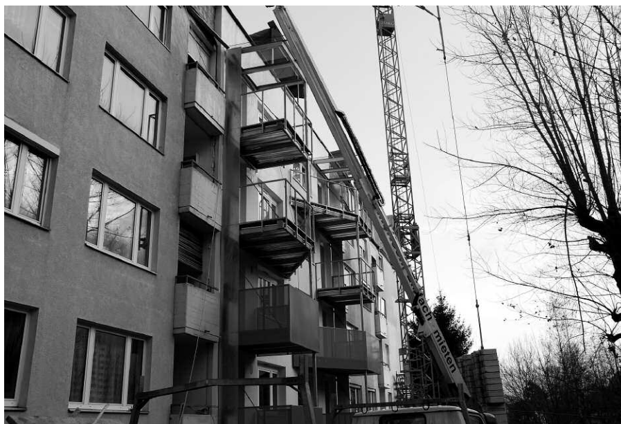
Sanierung im großvolumigen Wohnbau. BVH Richard-Knoller-Strasse, Salzburg Wohnbau
