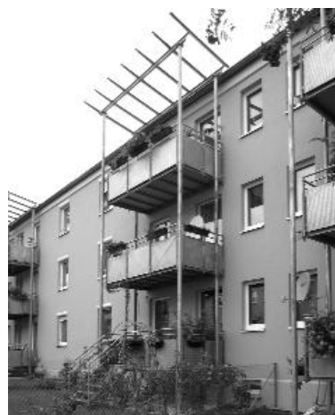
Modellhafte Sanierungen mit Wohnkomfortverbesserung
