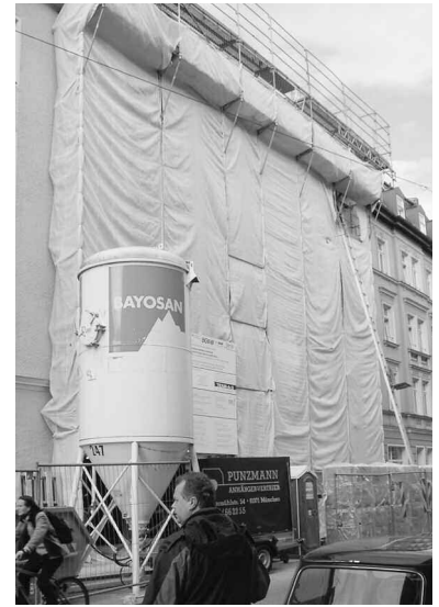
Eine Sanierung an einem denkmalgeschützten Objekt in der Innenstadt stellt rundherum eine Herausforderung dar. Resultat sind komfortable Wohnungen mit modernem Standard und niedrigen Heizkosten in zentraler Wohngegend.
