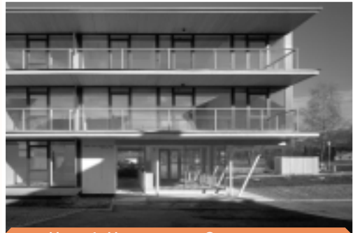
HALLE 1: HOLZWOHNBAU GLANTREPELWEG
