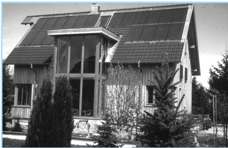
In die Dachhaut integrierte Sonnenkollektoren für die Warmwasserbereitung als sichtbares Zeichen intelligenter Energiebereitstellung
