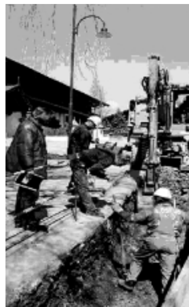
Verlegung des Leitungsnetzes im Alpendorf
