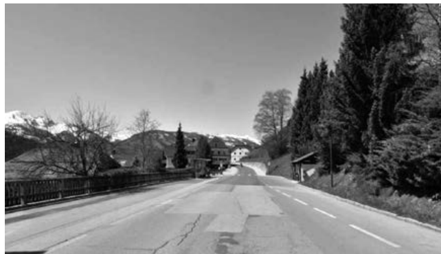
Status quo Schulhaltestelle: „Asphaltwüste“ und „Highway“ (Foto: R. Krasser)
