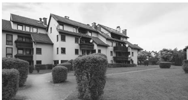
Blick in den Innenhof – vorher (2016), © Christof Reich
