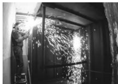
Demontage Öltank in der VS Lenzing, Saalfelden
