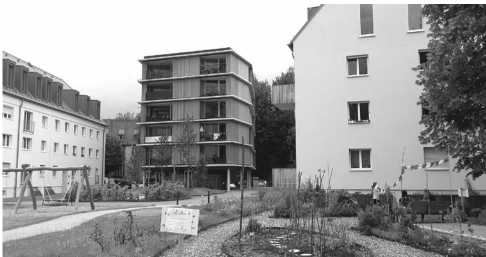
Siedlung Glanbogen – Beispiel für Neubau und Sanierung
