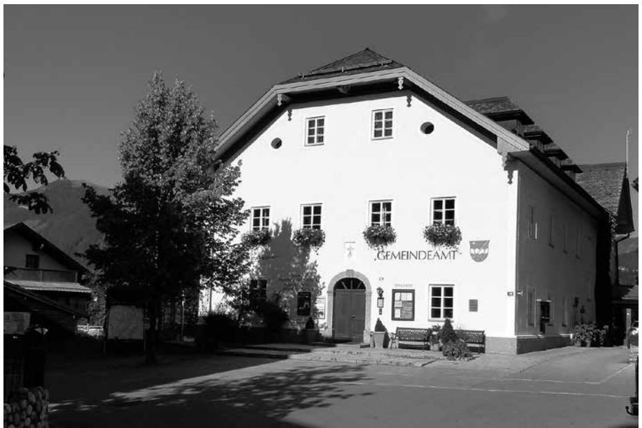
Beim Gemeindeamt St. Koloman steht ein Austausch der alten Ölheizung gegen eine moderne Pelletsanlage an. Auch das Feuerwehr- und Vereinsgebäude wird dann mit erneuerbarer Wärme versorgt. (Bild: Gemeinde St. Koloman)
