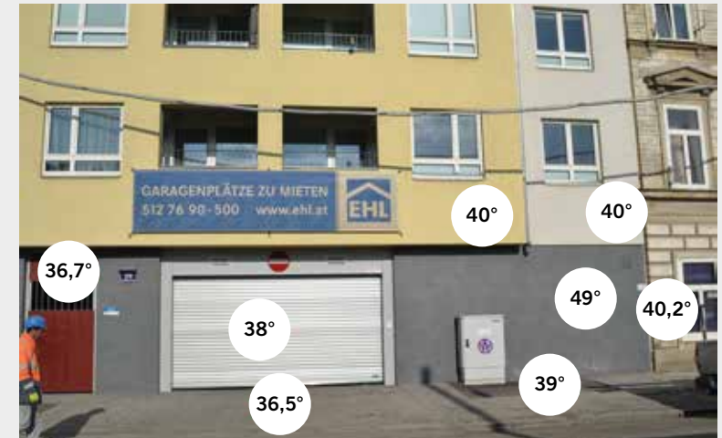
Temperaturunterschiede an den Fassadenoberflächen (nach Farben und Materialien) an einem moderat heißen Sommertag (Lufttemperatur 27°C)
