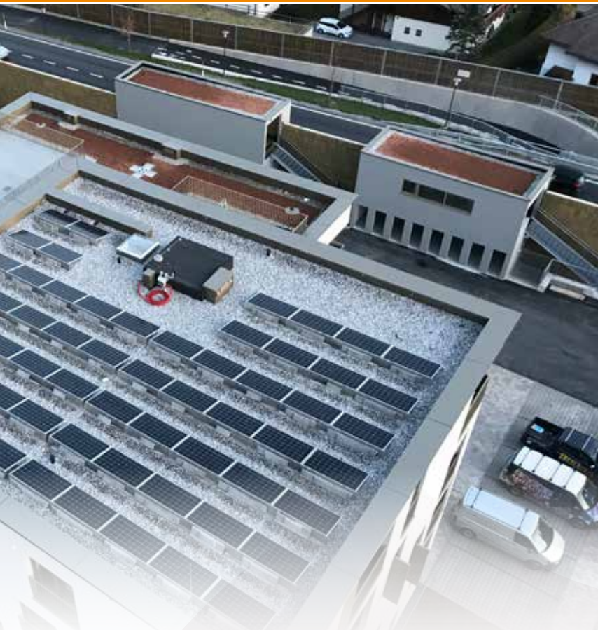
Jeweils auf einem Teil des Daches sind PV Module angebracht, der andere Teil kann als Dachterrasse von den Bewohnern genutzt werden.
