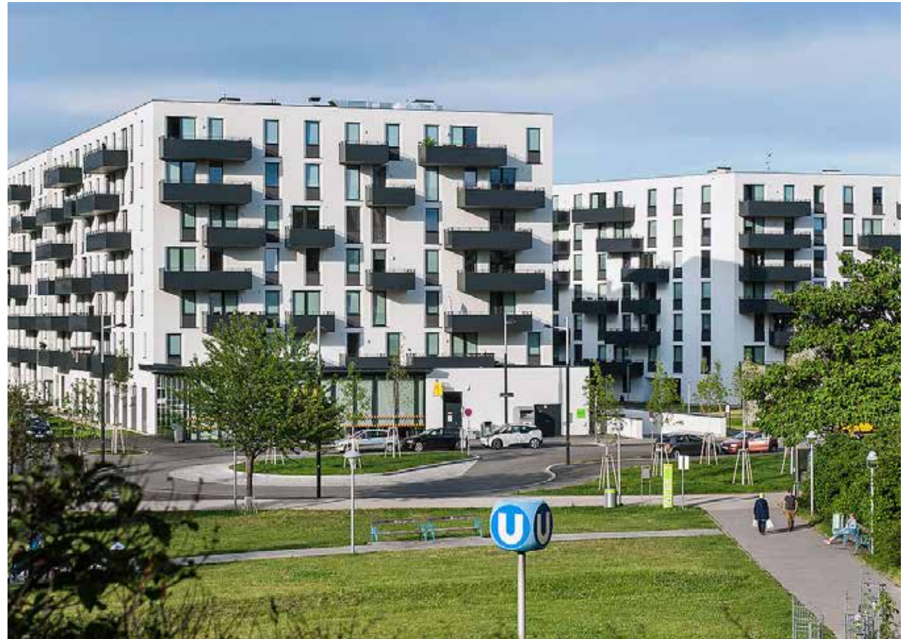
„Kostenreduziertes Wohnen in der Lorenz-Reiter-Straße in Wien: hier wurde aktive Bodenpolitik betrieben, indem Grundstücke frühzeitig gesichert wurden. Heute werden knapp 250 kostengünstige SMART-Wohnungen für Jungfamilien, Singles, Alleinerziehende und Kleinfamilien durch die Stadt Wien vergeben“ (Quelle: nextshot, Horst Dockal)
