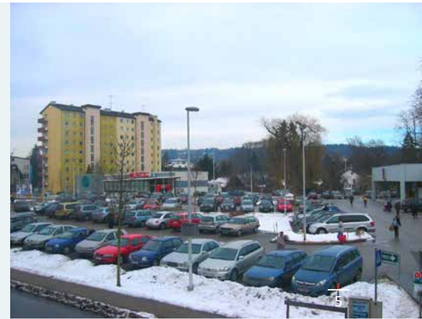
...und ein Supermarkt samt ebenerdigen Parkplatz desselben Handelskonzerns, der sich mangels planungspolitischer Vorgaben im Zentrum von Vöcklabruck verschwenderisch ausbreitet – während am Nachbargrundstück Menschen auf 10 Geschossen übereinandergestapelt werden. (Foto: Reinhard Seiß)
