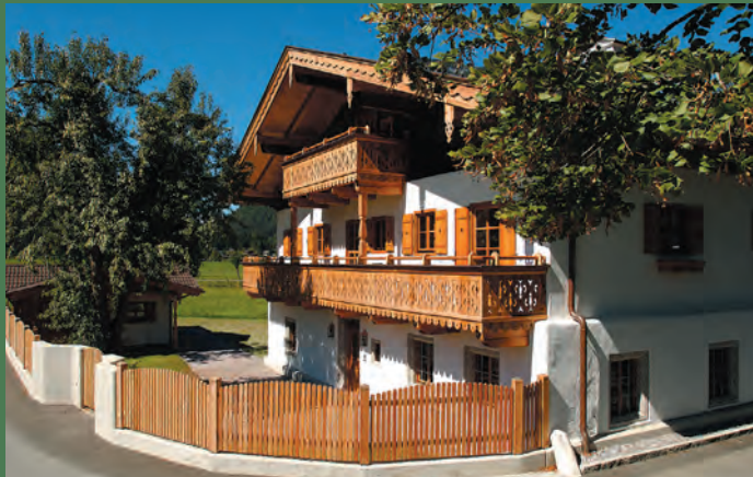
Sanierung in St. Martin. Fotos: Klaus Bauer
