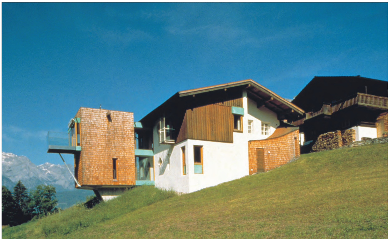
Das alte Austraghaus (Gebäude in der Mitte) wurde saniert und vorne um eine Haushälfte erweitert. Fotos: Hermann Eisenköck
