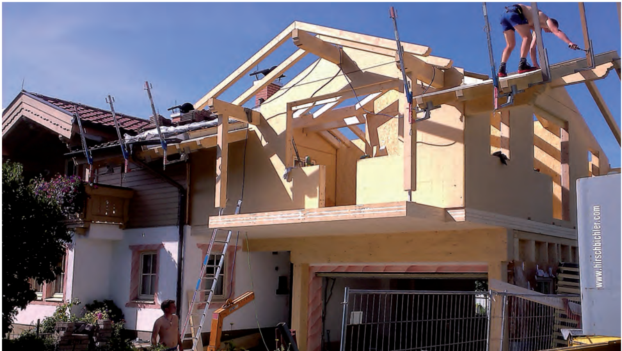
Neuer Wohnraum auf der Garage. Abb. Zimmerei Hirschbichler
