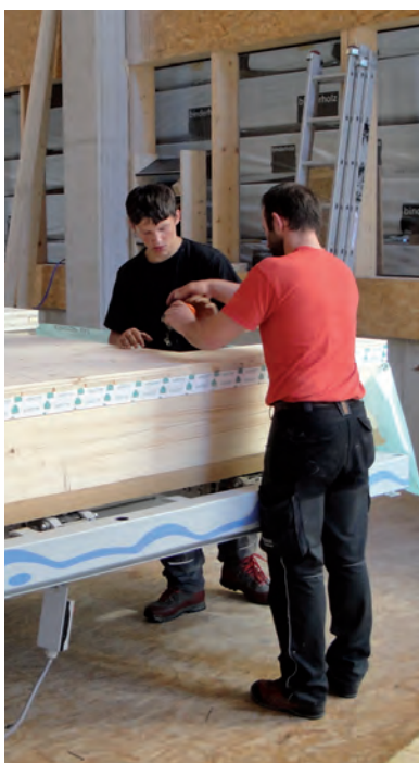
Abb. Wandvorfertigung im Holzbaubetrieb
