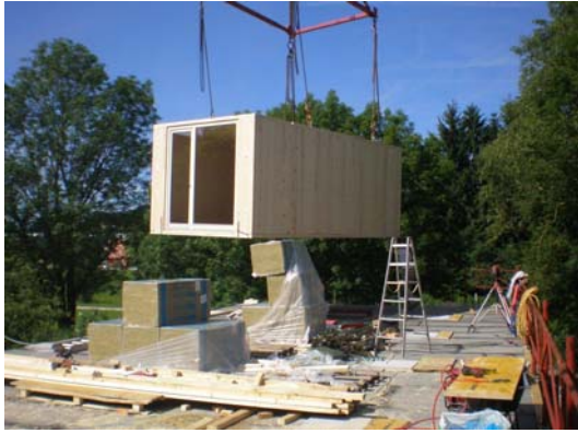
Abbildung 3: Transport der fertigen Raumzelle
