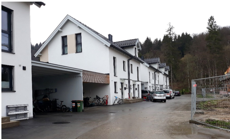
Abb. 5: Reihenhausanlage in Fürstenbrunn – DOMUS Bau Quelle: (SIR März 2022)
