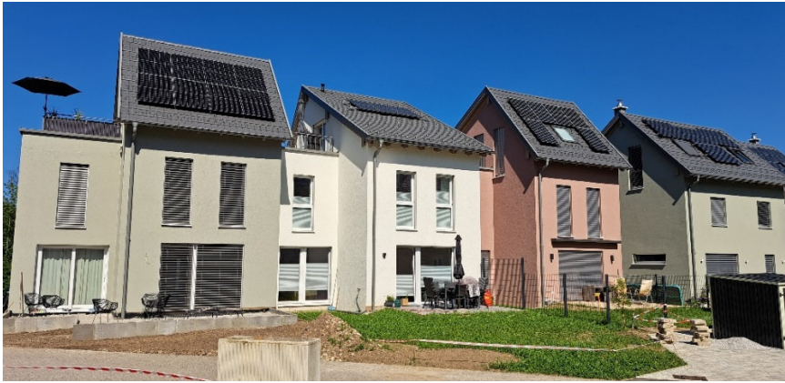
Abb. 15 Ansicht Südseite Juni 2023 / Quelle: SIR 2023
