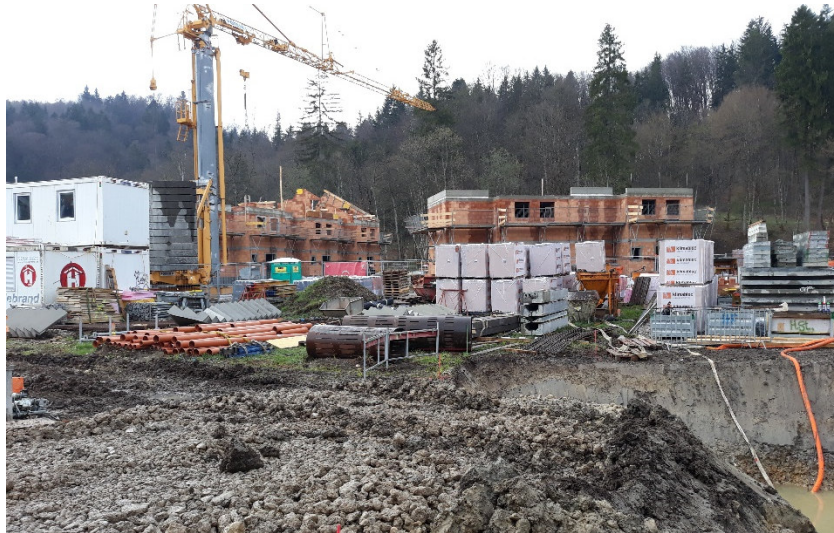
Abb. 13: Baustelle Wohnhäuser März 2022 / Quelle: SIR
