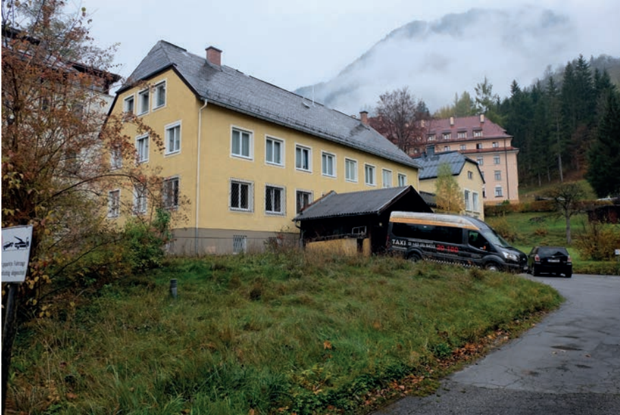
Gegenwärtig steht das Gebäude leer und Teile des Grundstückes werden zum Parken genutzt
