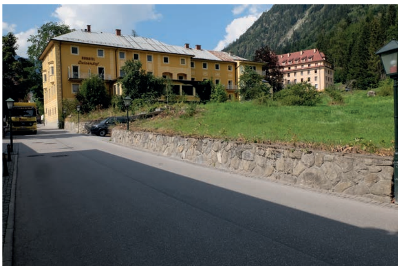
Nicht genutztes Hotelgebäude
