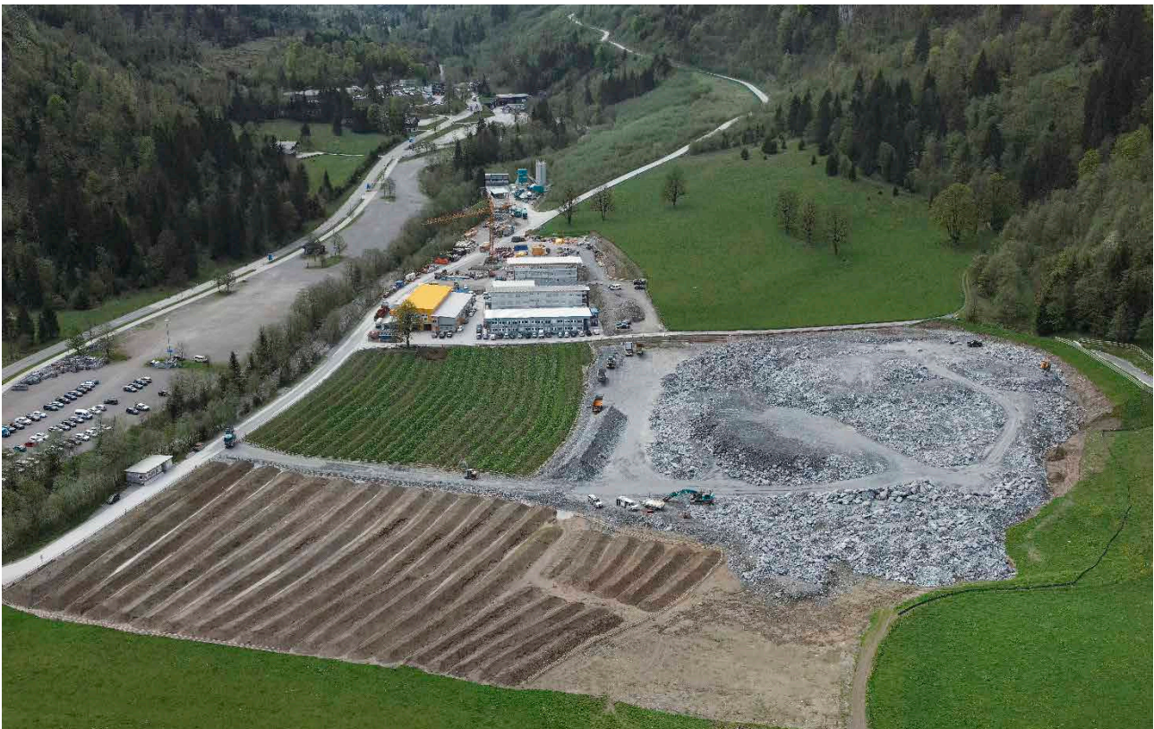
Sachgerechte Zwischenlagerung von Ober- und Unterböden im Bereich der Deponie Hinterwald Quelle: Verbund Hydro Power GmbH „Berichte der bodenkundlichen Baubegleitung“, Bild: Dr. Helmut Wittmann
