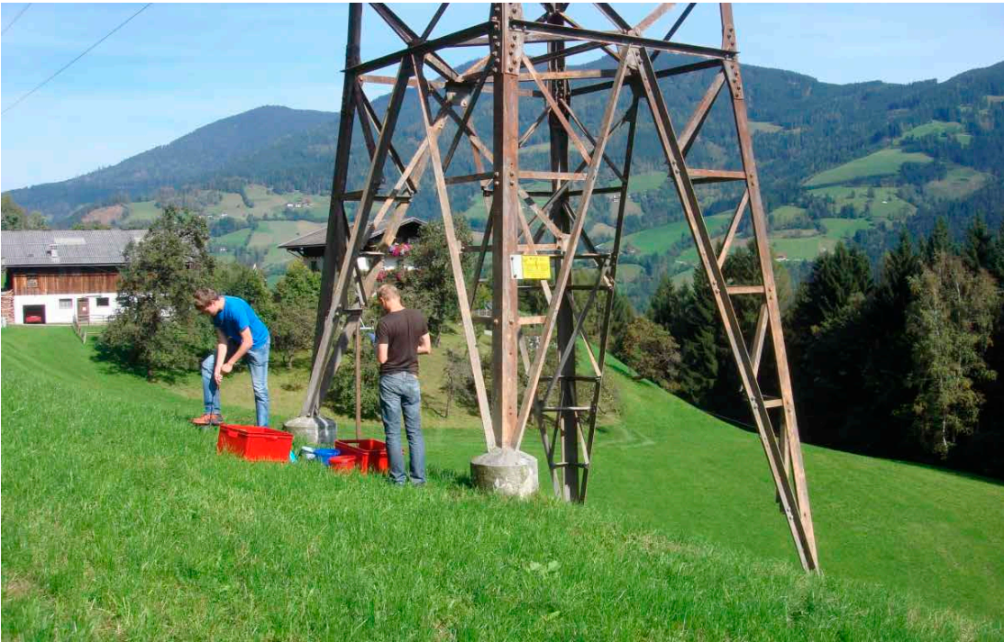
Probenahme bei einem Maststandort in St. Johann/Pongau (Bildquelle: Leist)
