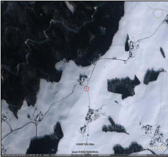
Abb. H.1: Luftbild des SO Haunsberg; Messtation als roter Kreis dargestellt. (modifiziert nach Google Earth)
