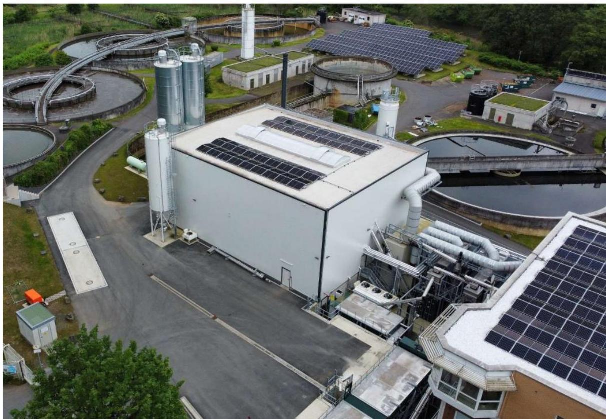
Abbildung 32: Referenzanlage Altenkirchen | 3 Linien @1.500 toTM/a<sup>13</sup>
