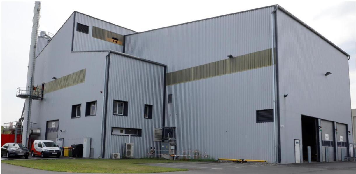
Abbildung 28: Wirbelschicht KSMVA (7.500 toTM/a) Großwilfersdorf (AT)<sup>11</sup>
