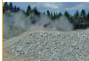
Nicht abgedeckte Bau-schutthalden sind der Winderosion voll ausgesetzt.
