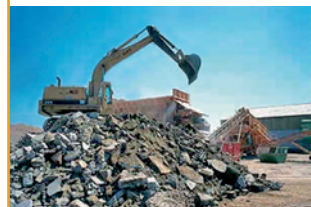
Bearbeitung und Zerlegung von Bauschutt erzeugt Feinstaub bzw. wirbelt diesen durch mechanische Vorgänge auf.
