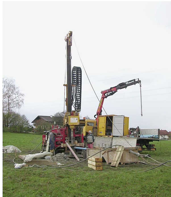
Errichtung eines Bohrbrunnens
