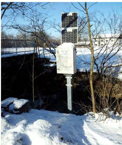
Abb. 18: Pegelmessstation und Probenahmestation am Schönbach
