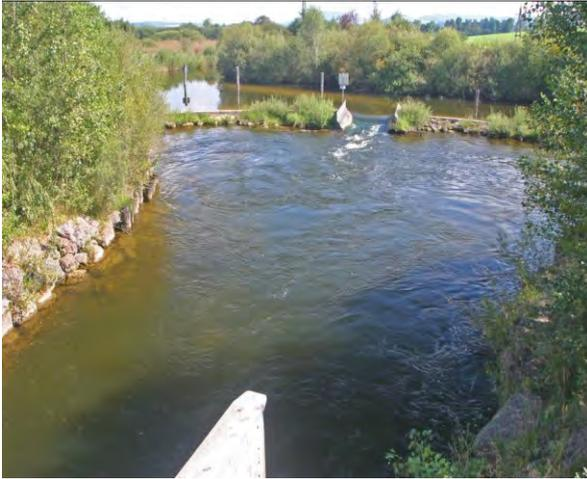
Abb. 17: Wallersee, Klauswehr Fischach; in der Mitte des Hochwasserüberfalles liegt die Niederwasserschwelle mit leichtem V-Profil (2010). (Foto: Paul JÄGER)
