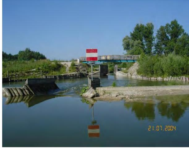
Abb. 18: Fischach, Damm und Klauswehr; im Vordergrund die Niederwasserschwelle, unter der Brücke die Klauswehre, welche den See bei Hochwasser dynamisch rückstaut und damit Hochwasserspitzen im Abfluss dämpft. (Foto: Paul JÄGER)
