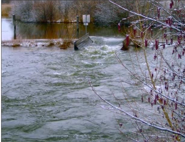
Abb. 4 a: Nieder-Mittelwasserschwelle in der Fischach während des Frühjahrshochwasser 2009. Die 30 m breite Schwelle ist bei diesem Abfluss bereits überstaut.
