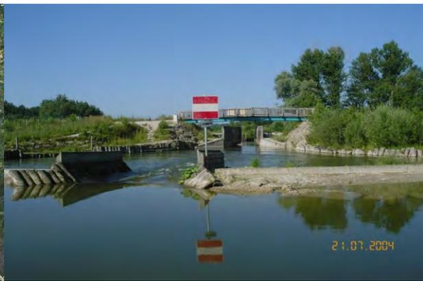
Abb. 6: Fischach, Damm und Klauswehr; im Vordergrund die Niederrwasserschwelle, unter der Brücke die Klauswehre, welche den See bei Hochwasser dynamisch rückstaut und damit Hochwasserspitzen im Abfluss dämpft. Foto: Paul JÄGER
