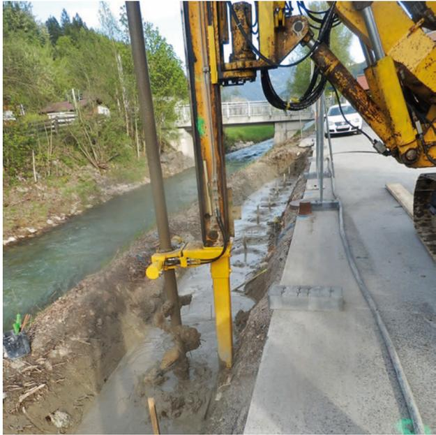
*Bodenverbesserung zur Fundierung HWS-Mauern*
