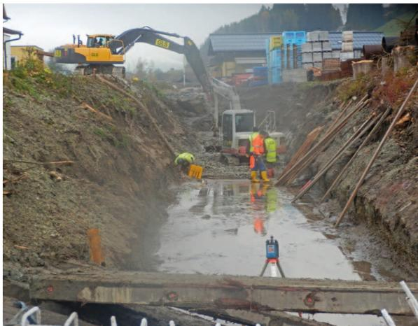
Aufwendige Tiefbauarbeiten bei der Verrohrung des Lohbaches.
