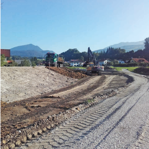
Schüttung Hochwasserschutzdamm
