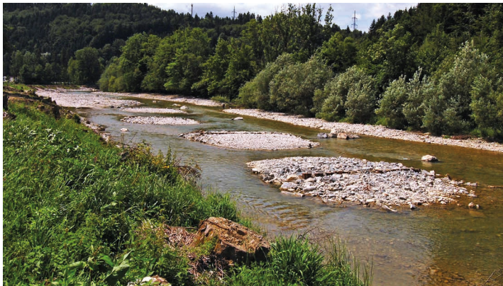
Aufweitung Almbach mit Strukturelementen
