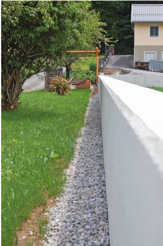
Hochwasserschutzmauer Bereich Rehrl
