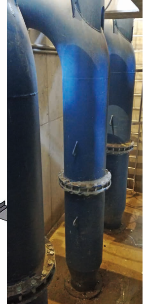
3 x Axialpumpen FBA 350/4, Firma Jank GmbH
