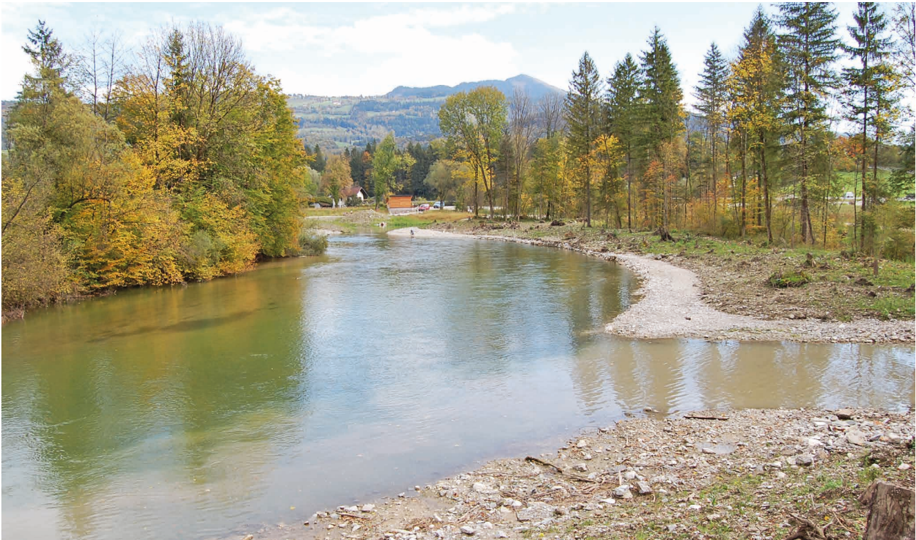
Einmündung Spumbach in den Almbach (o.li. vor Baubeginn)
