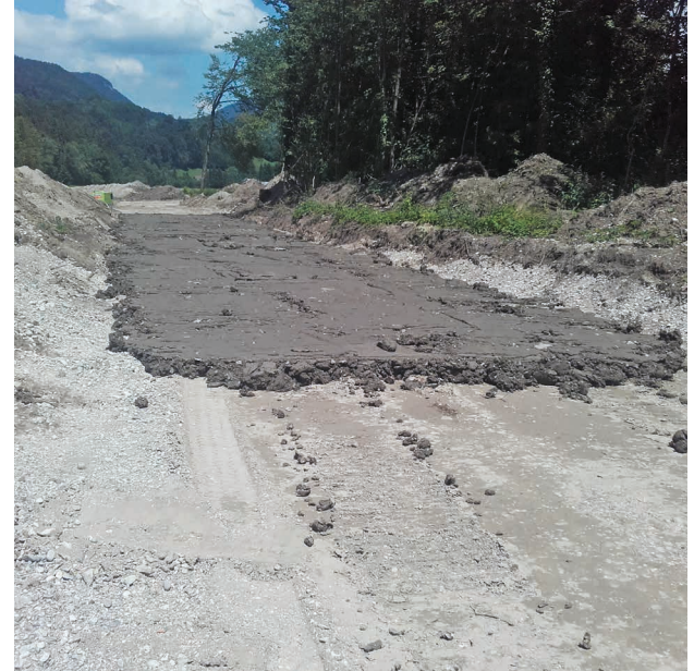
Dichtkern des Hochwasserschutzdammes
