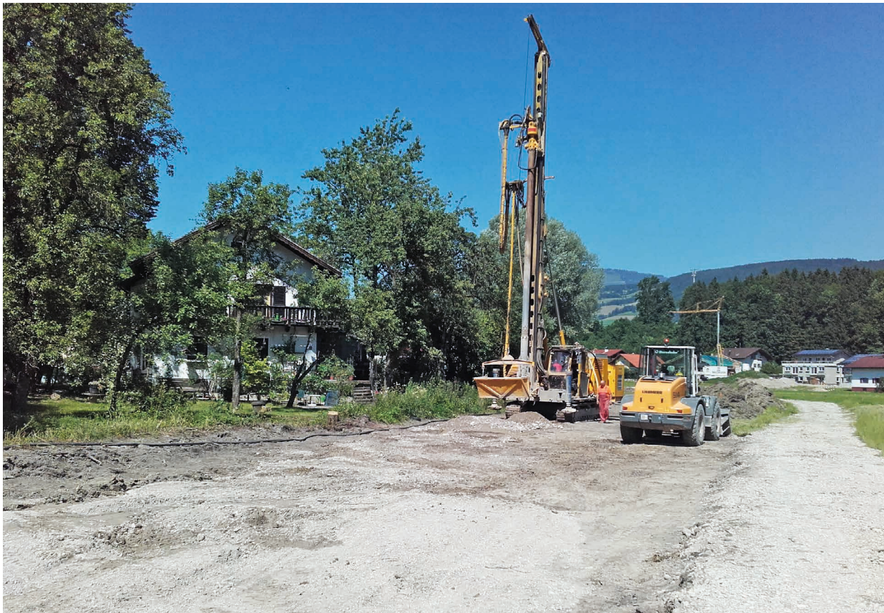
Bodenverbesserung des Untergrundes, Rütteldruckverdichtung (RDV)
