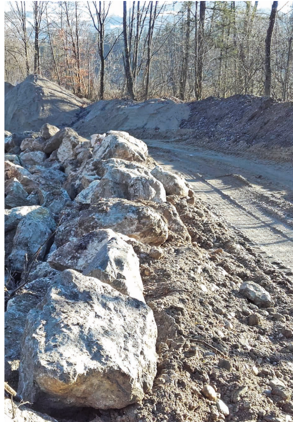
Herstellung der verdeckten Ufersicherung
