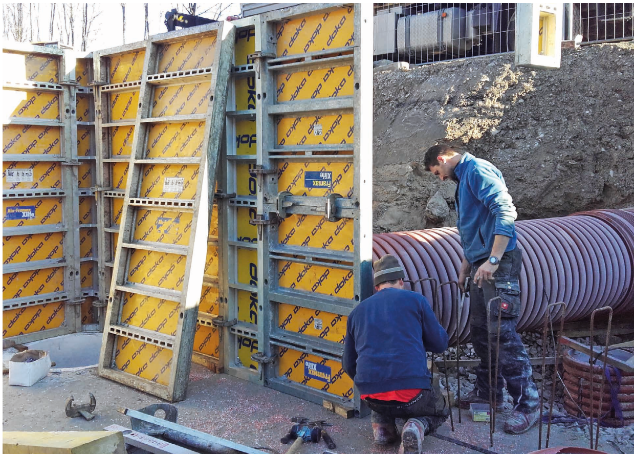
Bau Pumpwerk; Einbindung der Ringdrainage
