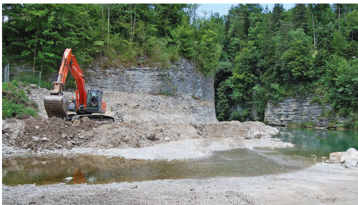
Neue Einmündung Spumbach, Abrisss Betonkanal
