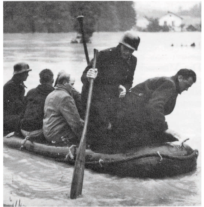
Hochwasser 1959, Bereich Zufahrtsstraße
