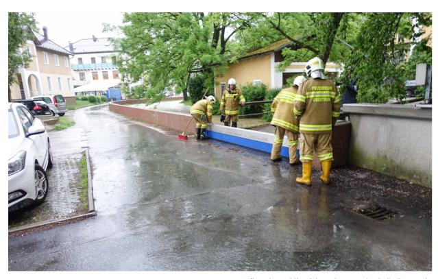
Aufbau der mobilen Schutzelemente durch die Feuerwehr
