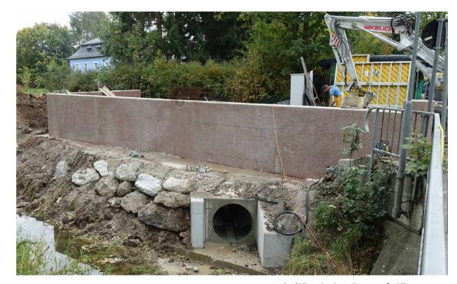
Auslauf Hinterlandentwässerung, Stahlbetonmauern
