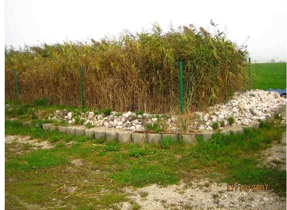
Abb. 5b: Vertikalfilter nach längerem Betrieb
