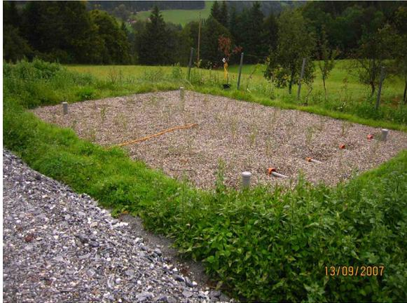
Abb. 5a: Vertikalfilter kurz nach Baufertigstellung
