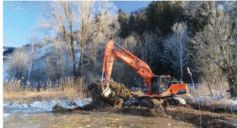
Mit Hilfe des Baggers konnten im Amphibienteich in Thumersbach Wasserbereiche mit mehr als 1.5m Tiefe sowie schnell erwärmende Flachwasserzonen geschaffen werden.
