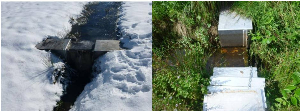
Beispiel eines regulierbaren Wehres im Moor Örtliweid, Kanton Zürich, Schweiz. Außerhalb der
