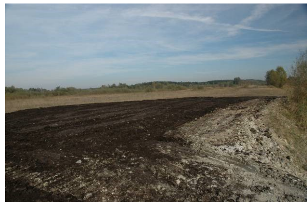
Abb. 12: Durch die gezielte Bearbeitung der Torfoberfläche im Zuge der Bauarbeiten wurden ausgedehnte vegetationsfreie Flächen geschaffen (Ragger).
