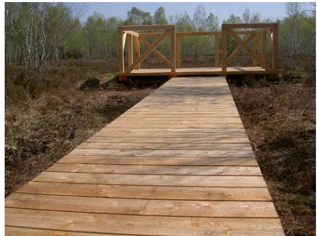
Abb. 34: Neu errichteter erster Teilabschnitt des Themenwegs kurz nach der Fertigstellung im April 2004: Bohlenweg mit Aussichtsplattform im Hochmoorrest (Ragger)
