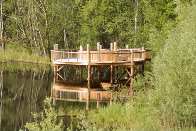
Abbildung 1-9: Neue Aussichtsplattform im Bereich der Infostelle
