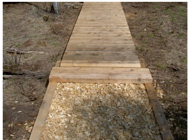
Abb. 35: Übergang vom Bohlenweg zum Hack-schnitzelweg mit Randeinfassung aus Lärchenholz (Ragger)
