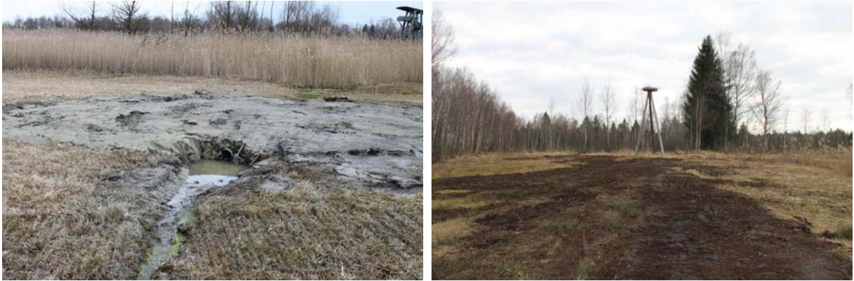
Abbildung 6-6: Sanierung der Überfahrt (Pkt. 7, vgl. nachfolgende Abbildung) und Einebnen der Bockerlbahntrasse sowie verfüllen der Fahrspuren beim Storchennest (Fotos Ortner)
