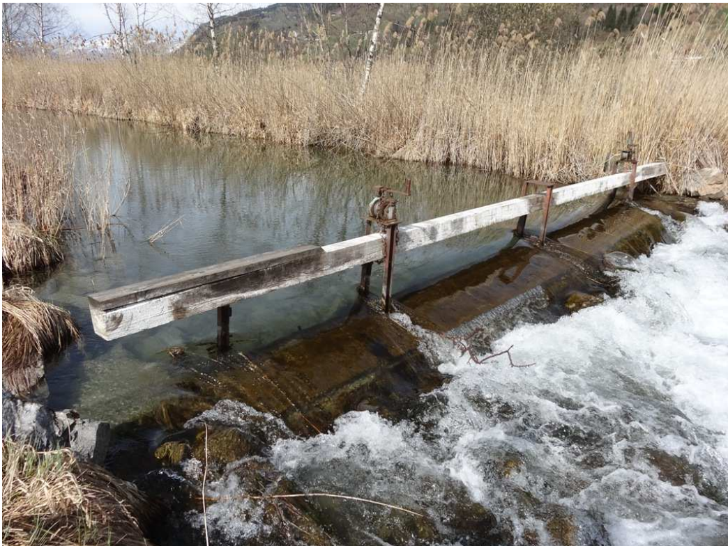
Abb.15: Schwelle am grossen Seekanal.
